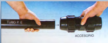
Aproximación del tubo de P.E. al accesorio
